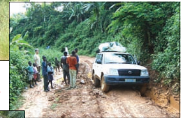
80% de carreteras en malas condiciones
